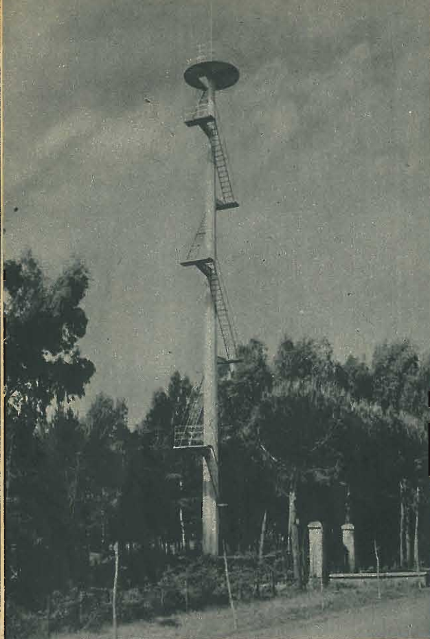
L'osservazione dall'alto della torre di vedetta contro gli incendi costituisce il mezzo più efficace per avvertire l'improvviso divampare delle fiamme
